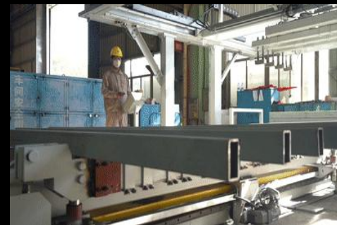
Automatic welding 自动装焊
